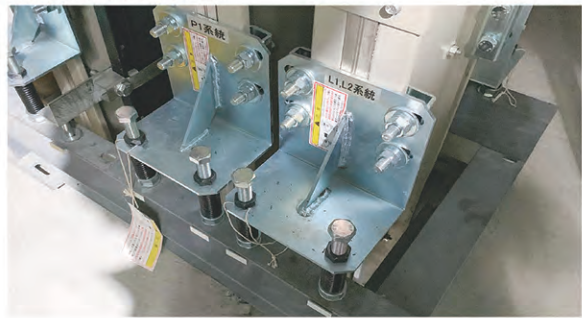
■施工例「バスダクト貫通枠」
