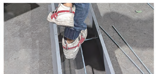
■落下防止金物 試験
