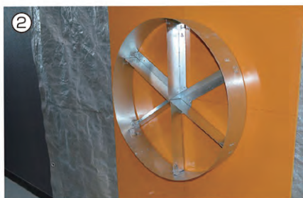
すみ出し後、アンカー取付(クギまたはビス) ※現在は新仮枠アンカー
