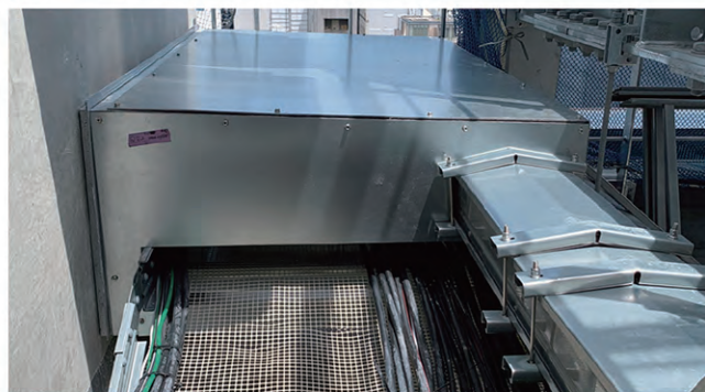
フードカバー 施工後
