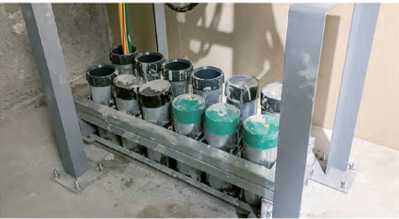
■施工例「貫通枠」
